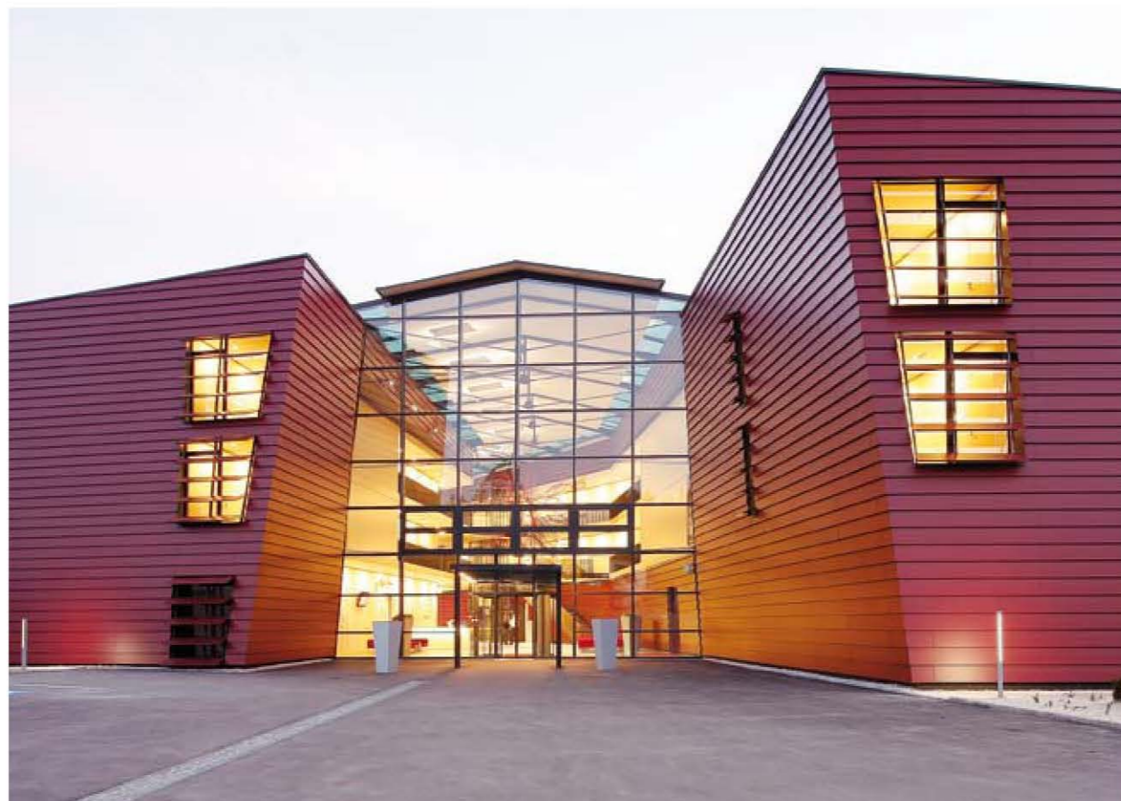
Die beiden Baukörper des Spa Hotels Bründl in Bad Leonfelden fügen sich harmonisch in die Landschaft ein. Form und Farbgebung vermitteln erdiges Selbstbewusstsein. Eine dreigeschossige Eingangshalle verleiht dem Komplex die nötige Portion Transparenz.
