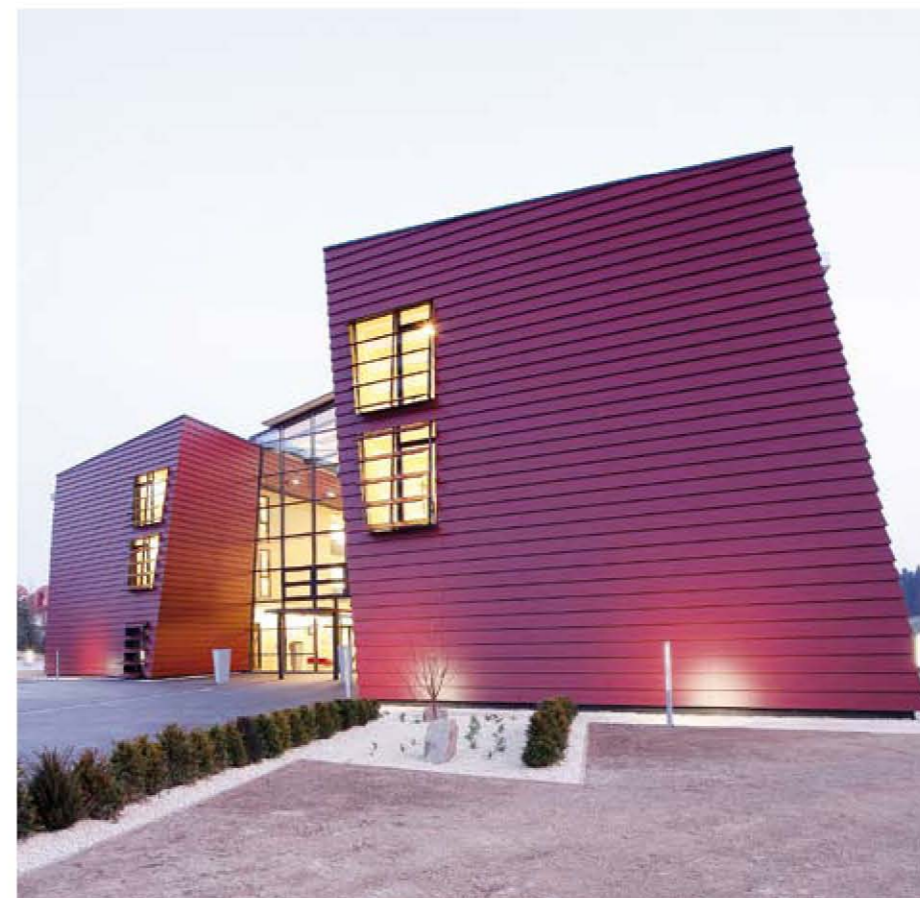
Horizontale Schichtung und Erdschnitte – das architektonische Thema zeigt sich im geknickten und aus der Höhenachse gedrehten Gebäude. Die Haut besteht aus geschuppten Maxplatten.
