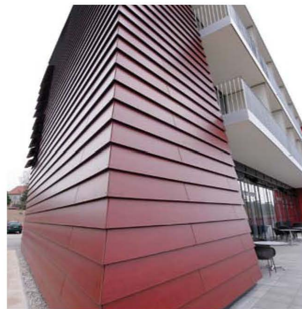
Die äußerlich verdrehende Hülle lässt offene und geschlossene Balkone entstehen, die in die Hülle geradezu hineinschlüpfen.
